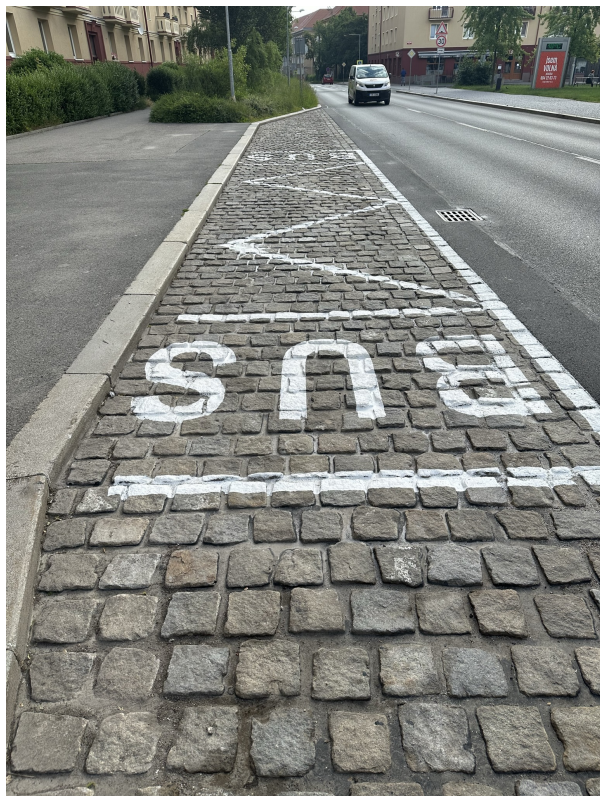
Obr.1 Spárořez dlažby autobusového zálivu
